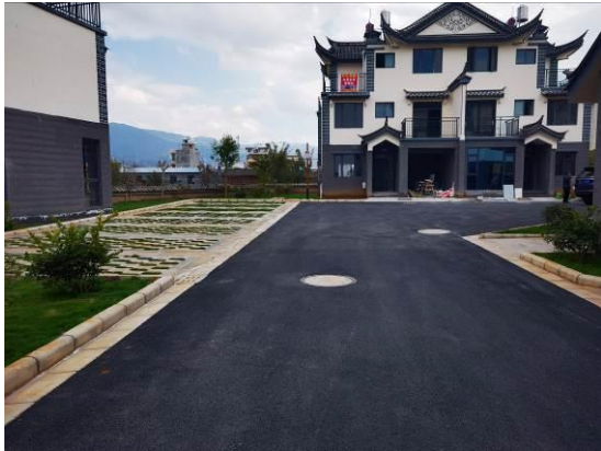
道路硬化区（2022年3月）
