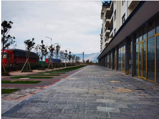
道路硬化区（2022年3月）
