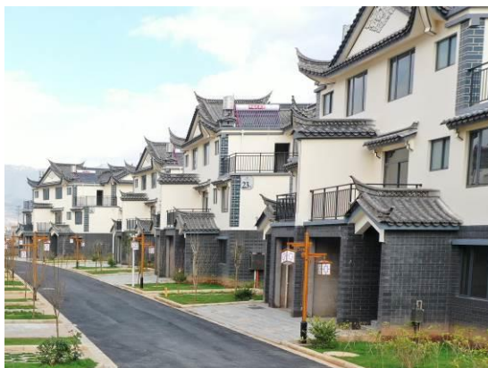
建构筑物区现状 (二) (2022 年 3 月)
