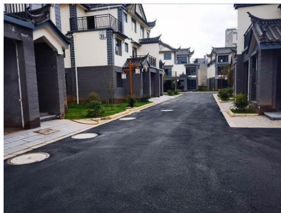
道路硬化区现状（二）(2022年3月)
