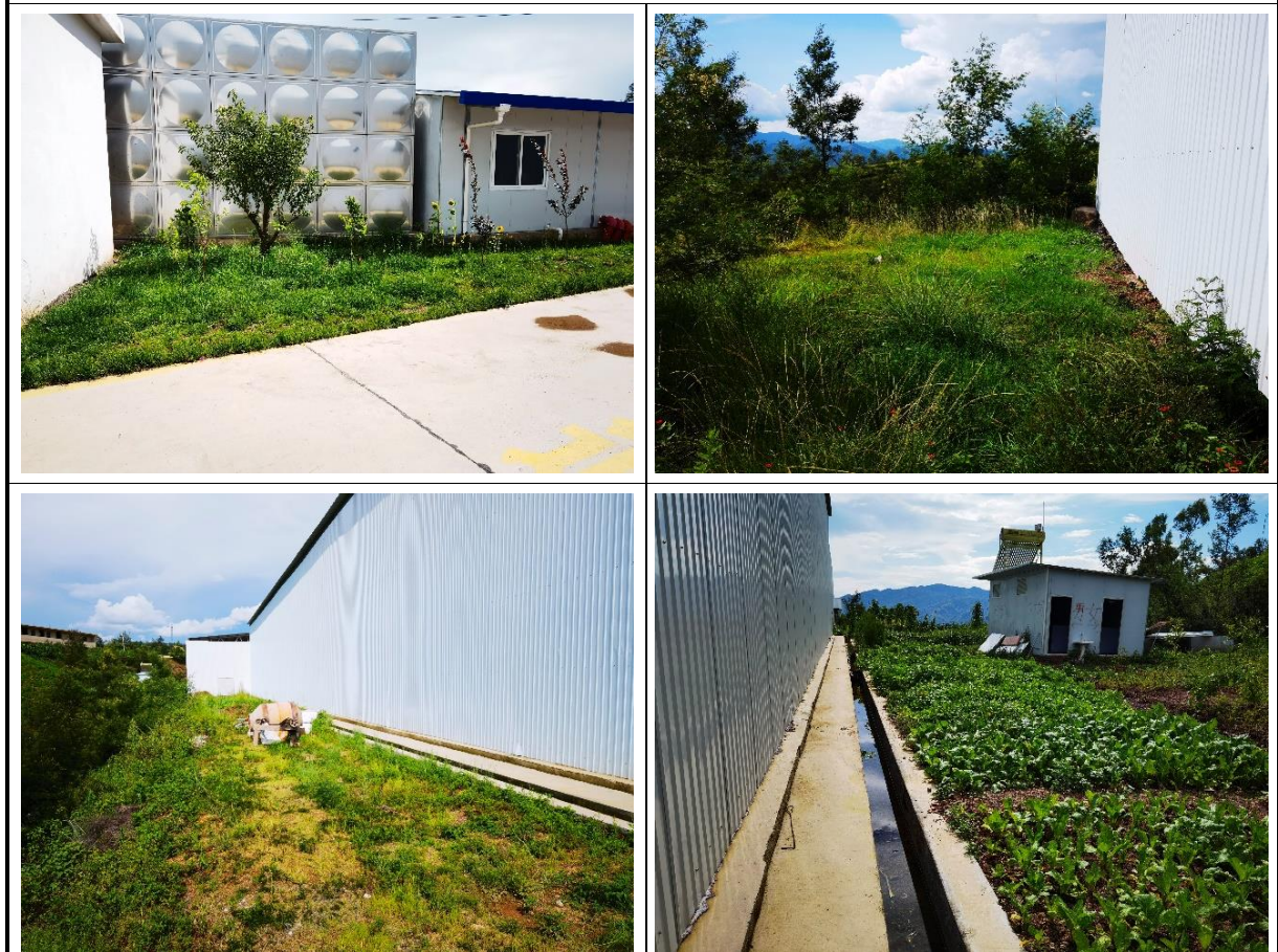
撒草绿化现状（植物措施）
