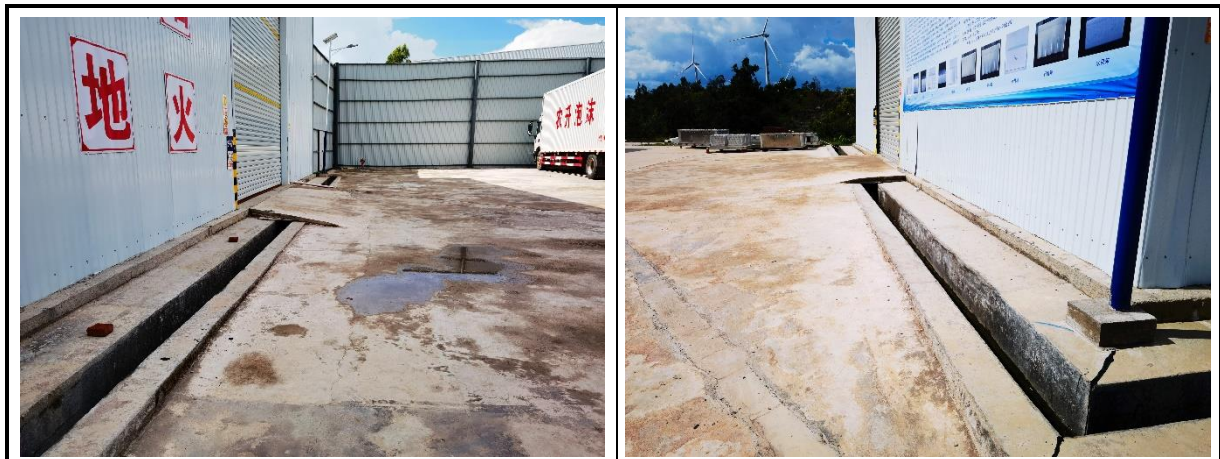
砖砌排水沟现状（工程措施）
